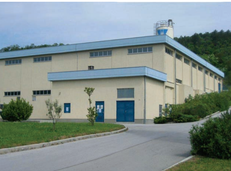
Slika 5: Čistilna naprava Rižana (foto: Uroš Krajnc)
